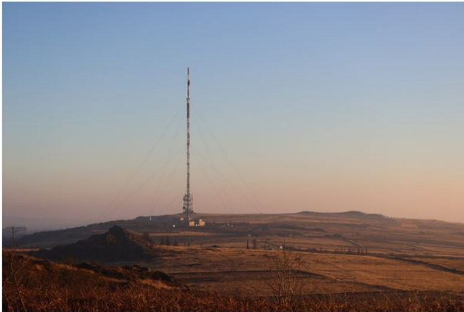
Figure 1: Station de Roc'h Tredudon, dans les Monts d'Arrée en Bretagne
